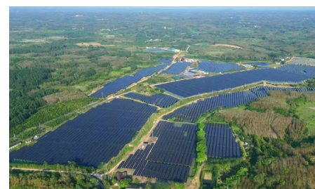
海南定安柔性支架项目
